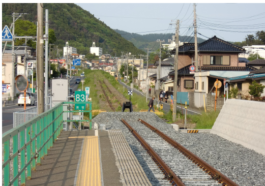
浦宿(うらしゆく) 駅ホームから女川方面を見る。 線路は途切れたまま。
