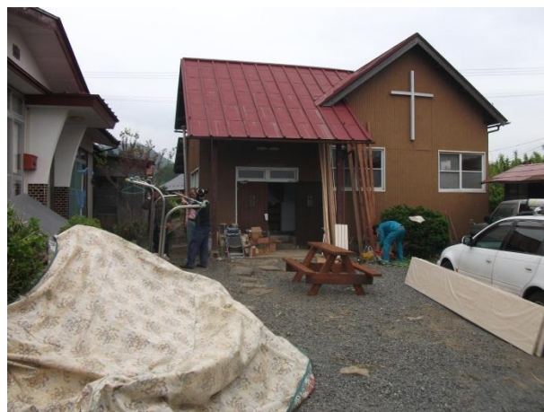
修復工事中の室根聖ナタナエル教会
