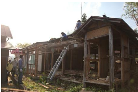
左：伝道師館解体作業
