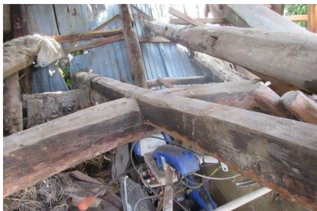
太い柱の下敷きになった管理機
