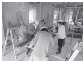
会館での塗装作業
