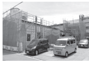
左側は建設中の礼拝堂、右側一階は会館、二階は牧師館・エレベーター付き
