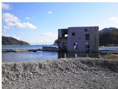
震災の地盤沈下で海面に没した南三陸女川町の市街地。4階建てのビルが横倒しになっている。
