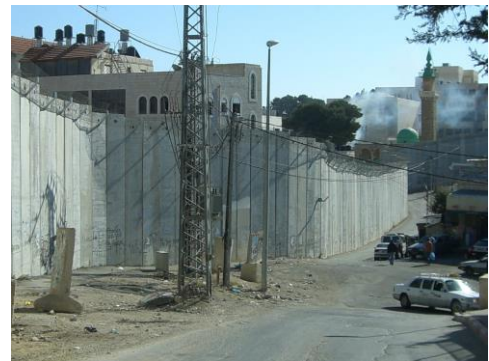
〈写真〉エルサレムに建設中の壁
